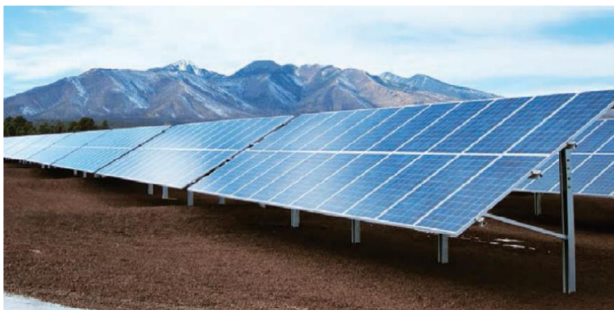
Slika 2.4 Montažna konstrukcija - stol (Izvor: Idejno rješenje)
